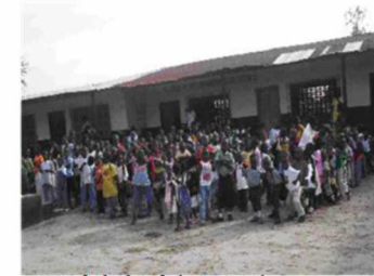
CYE Schulgebäude in Monrovia
